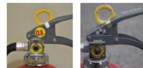
○ 使用済みの表示装置 × 表示装置の脱落
